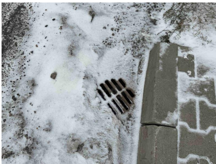
Rysunek 14. Kratka kanału ściekowego usytuowana na styku z istniejącym fragmentem ciągu pieszego w ciągu ul. Kolejowej. (Źródło: własne)
