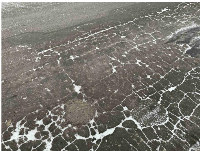
Rysunek 6. Liczne spękania nawierzchni ulicy Kolejowej. (Źródło: własne)
