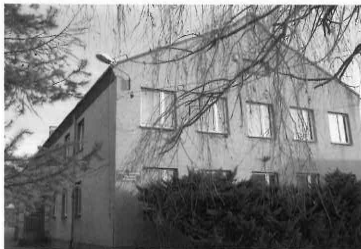
Budynek szkoły podstawowej obecnie Niepublicznej Szkoły Podstawowej w Pyrzowicach
